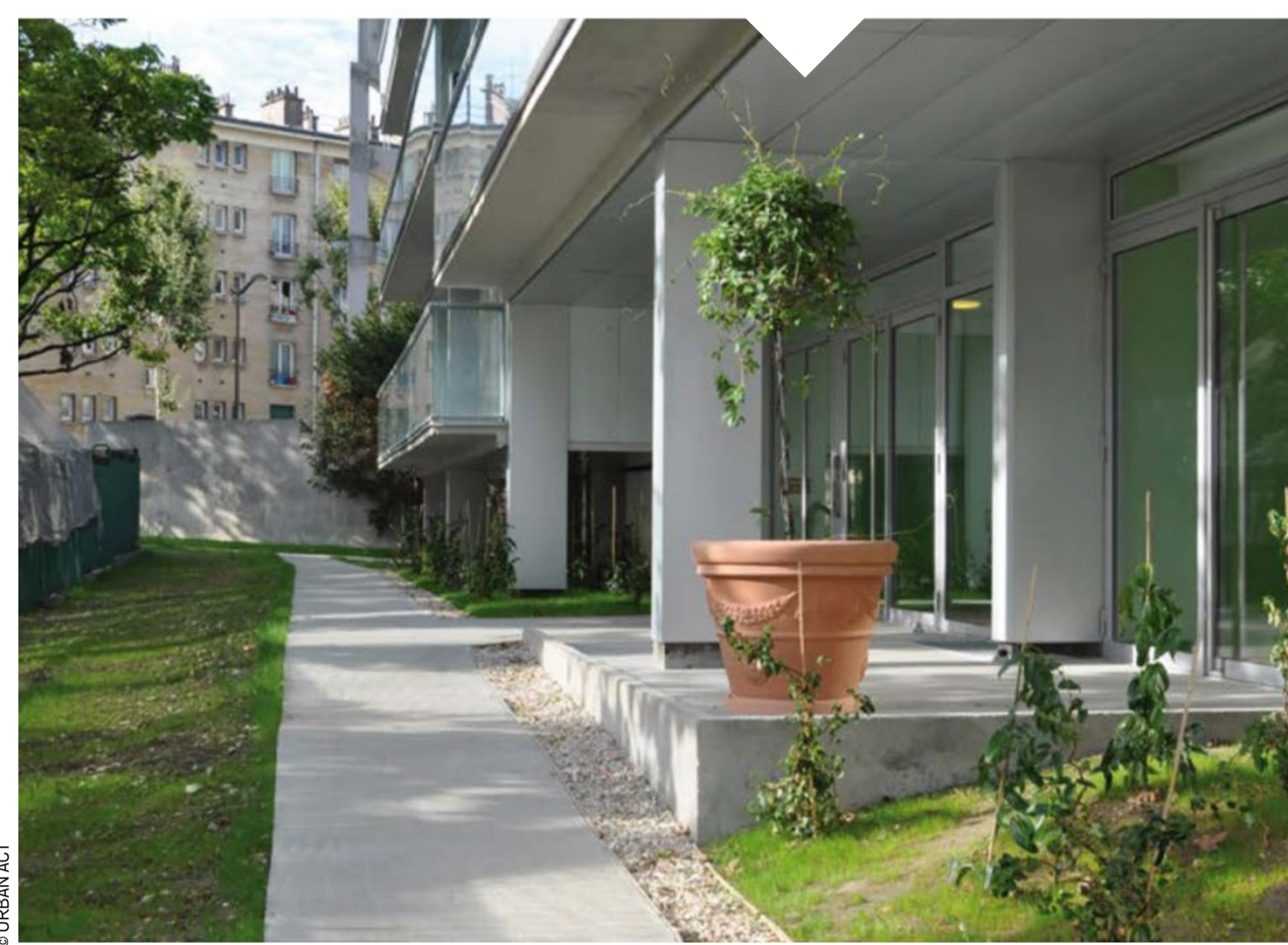
Un exemple de résidentialisation : amélioration des pieds d'immeuble
