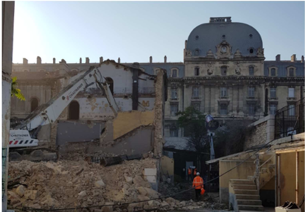
Démolition de la caserne Marceau (Crédit : Ville de Marseille).
