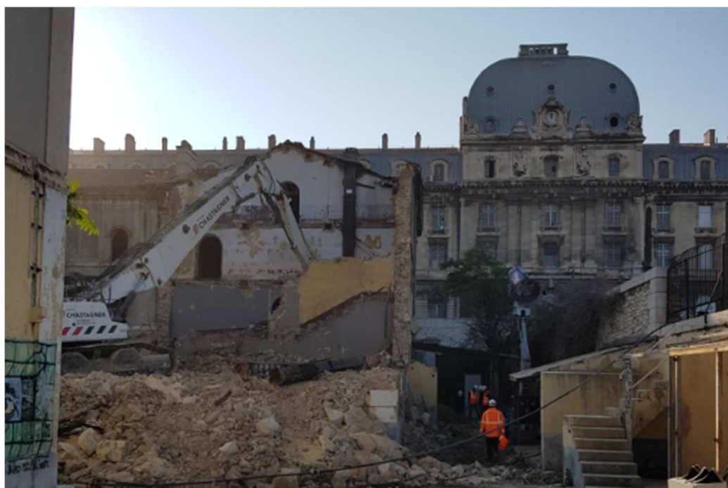
Démolition de la caserne Marceau (Crédit : Ville de Marseille).
