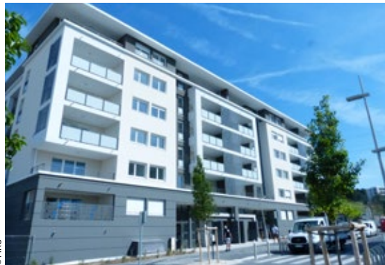
B Les Hauts de l'Etoile 48 logements sociaux, rue Elie Kakou / Unicil / 2017 (2H architecture)
