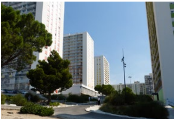
C Résidentialisation des espaces extérieurs 1 re tranche / 601 logements / Unicil / 2015 (Architectes : Barriquand & Frydlander)
