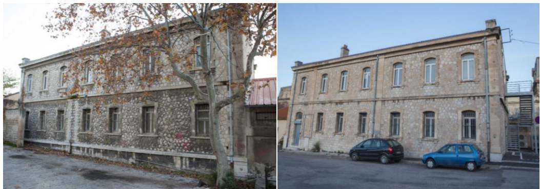
Le Pavillon Belle de Mai avant et après les rénovations (Crédit : Dplab).
