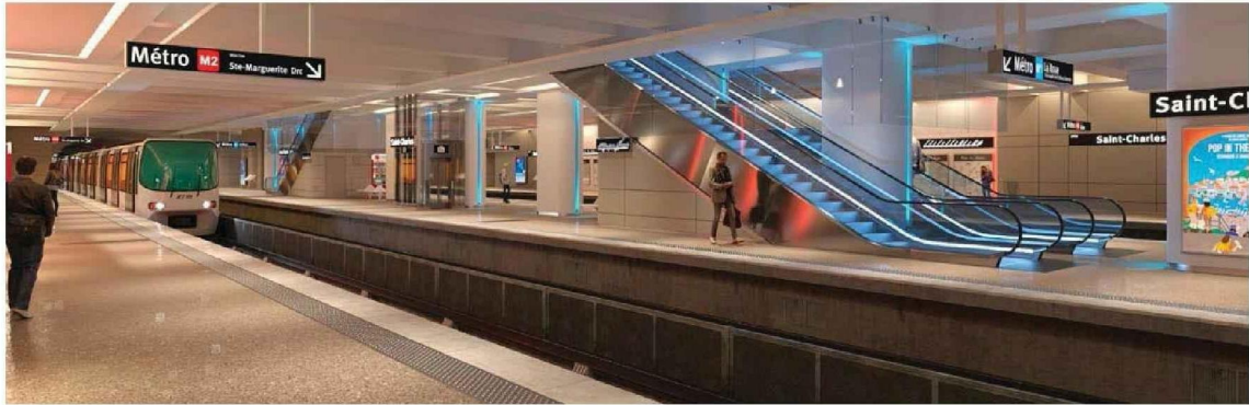
Peau neuve. Des quais élargis, de nouveaux escaliers fixes et roulants : une partie des travaux de rénovation de la station de métro Saint-Charles est achevée.
